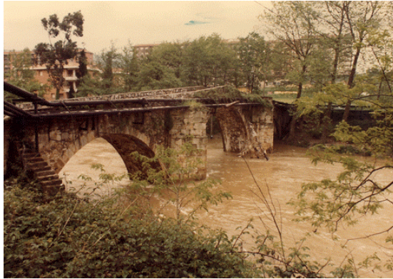
PUENTE DE TORREZABAL
