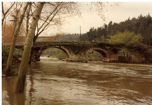
PUENTE DE LA TORRE
